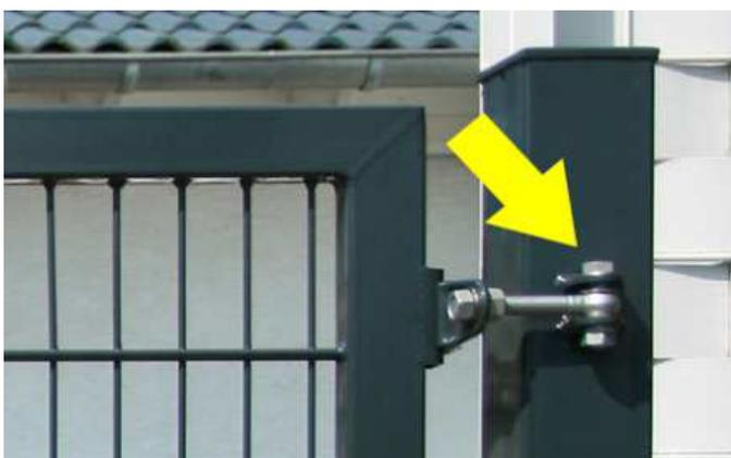
Achten Sie bei der Pfostenmontage darauf, dass die angeschweißten Aufhängelaschen des Scharnierpfostens in die Richtung der späteren Toröffnung zeigen.
