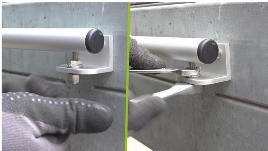
**Hinweis:** Bei diesem Schritt löst sich der Sicherungsstift der Vorspannung meist von selbst. Sollte der Stift im Gartentorschließer verbleiben, bewege das Gartentor einfach für wenige Millimeter in die Öffnungsrichtung!
