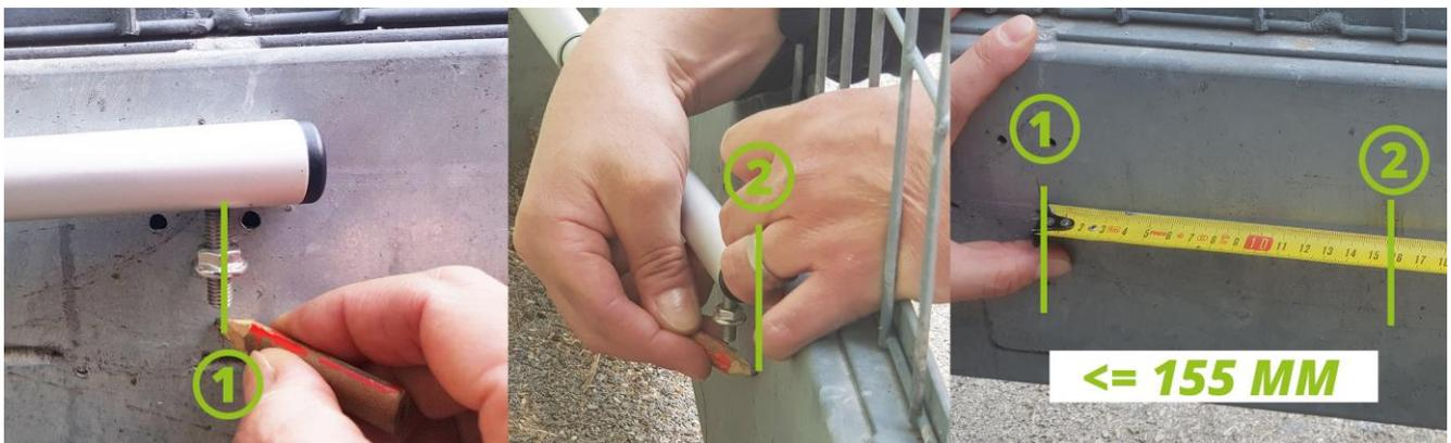
Beträgt der **Abstand dieser beiden Markierungen rund 155 mm**, ist die Lage des Winkels **optimal**. Ist er etwas **kleiner**, solltest Du den **Abstand B** etwas **erhöhen**. Ist der Abstand **größer als 155 mm**, dann muss der **Abstand B** verringert bzw. ein anderes Montageloch am Winkel 1 gewählt werden.
