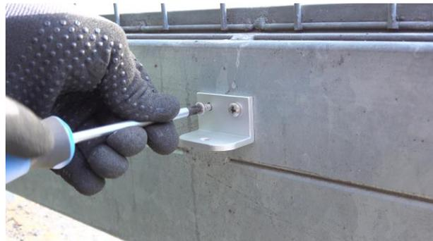
Danach können die Bohrlöcher analog zu Schritt 4 erstellt und der Winkel mit den beiliegenden Schrauben befestigt werden.
