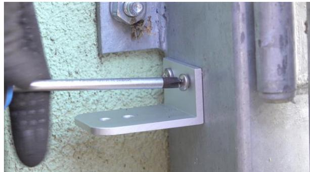
Nachdem die Löcher erstellt sind, wird der Winkel mit den Blechschrauben befestigt.
