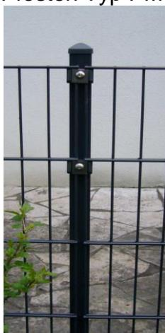
Der Pfosten Typ PM entspricht vom Grundsatz dem Pfosten Typ A. Anstelle der Abdeckleiste werden hier Edelstahlplättchen mit Zaunbauschrauben zur Befestigung verwendet. Die Anzahl der Befestigungspunkte richtet sich nach der Zaunhöhe.
