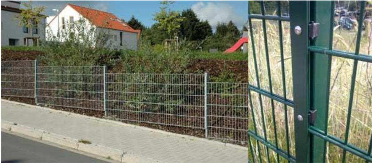
Bei Steigung und Gefälle im Zaunverlauf mit weniger als 20 cm Differenz auf einer ganzen Matte versetzt man ohne Einkürzung der Matte. Ist jedoch die Differenz höher, halbiert man ein Gittermattenelement und benutzt einen zusätzlichen Pfosten.
