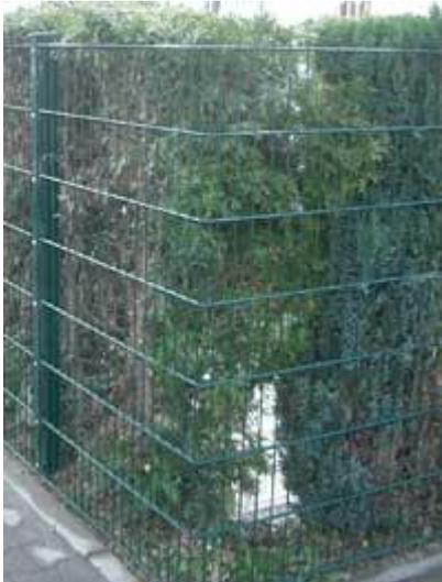
Es ist ebenfalls möglich den gewünschten Winkel durch Biegen des Doppelstab Gitterzaunelements herbeizuführen. Dazu wird jeweils ein ca. 3 cm Stück des inneren waagerechten Doppelstabs herausgeschnitten und zwar über die gesamte Zaunhöhe hinweg. Nun kann das komplette Element an dieser Stelle individuell dem erforderlichen Winkel angepasst werden.
